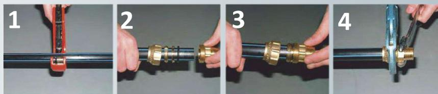
**Foto n ° 1** - Marque y corte el tubo perpendicular a su eje con un cortador de tubo o una sierra de dientes finos, el tubo debe estar marcada para que inserta en el cuerpo, el primero del atornillamiento de la tuerca tiene una oportunidad de asentarse en la parte inferior de su sede de unos 3-5 mm. La tubería debe ser cuidadosamente rebabas de manera que no se dañe la junta tórica.
